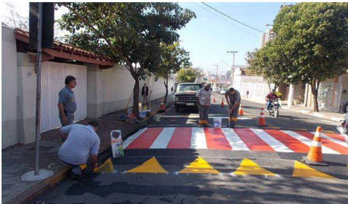
FIGURA 71 – Lombofaixa instalada em uma avenida.
