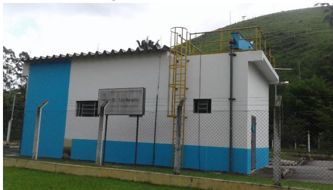
Foto 14: Estação de Tratamento de Esgotos (E.T.E.) do Bairro de São Benedito município de Monteiro Lobato. Foto: Pivott (2019)
