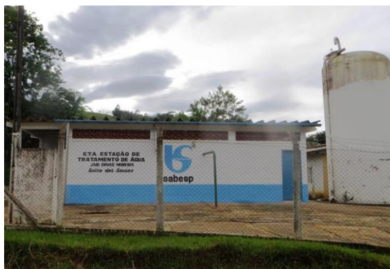
Foto 11: Estação de Tratamento de Água (ETA) Bairro dos Souzas no município de Monteiro Lobato.
