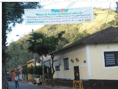
Antes da reforma
