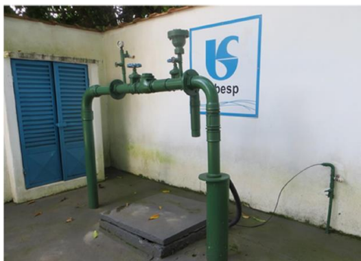
Foto 12: Poço tubular profundo no bairro de São Benedito, município de Monteiro Lobato. Fonte: IPT (2016)
